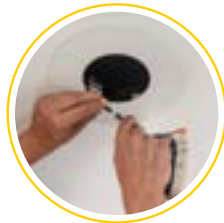
5. Raccord électrique et installation du nouveau plafonnier encastré.
